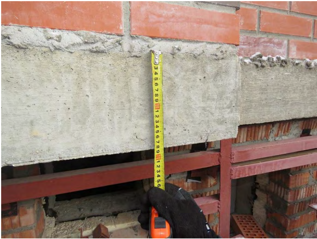
Рис. 3.3.3. Замер толщины монолитной ж.б. плиты перекрытия
