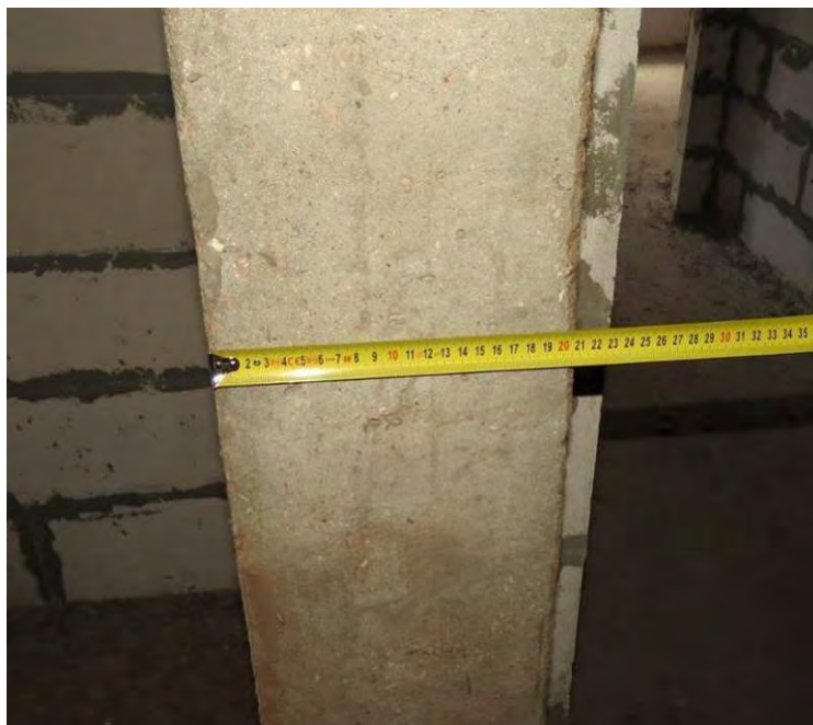
Рис. 2.1. Замер толщины монолитного ж.б. стены пилона типового этажа при помощи металлической рулетки
