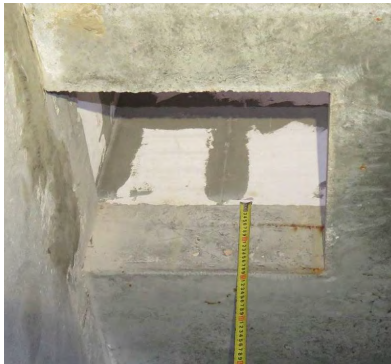
Рис. 2.2. Замер толщины плиты перекрытия подвала при помощи металлической рулетки
