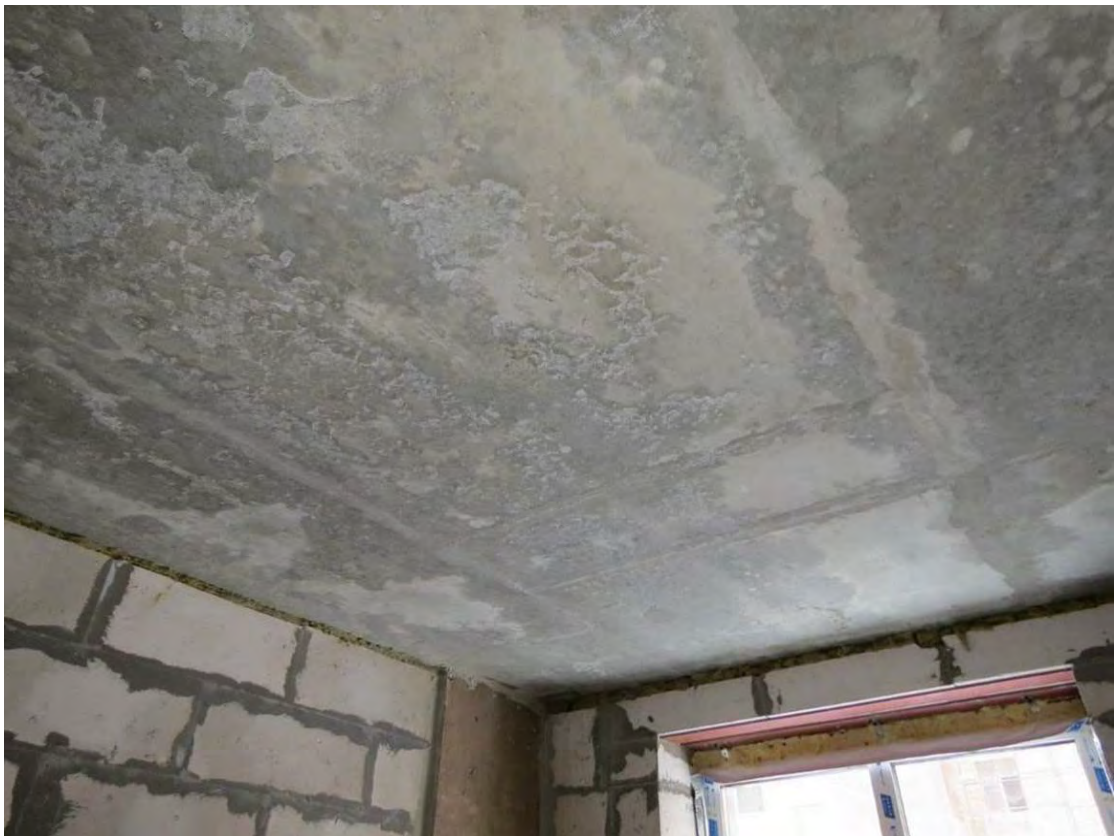
Рис. 3.3.2. Общий вид монолитной ж.б. плиты перекрытия 2-го этажа
