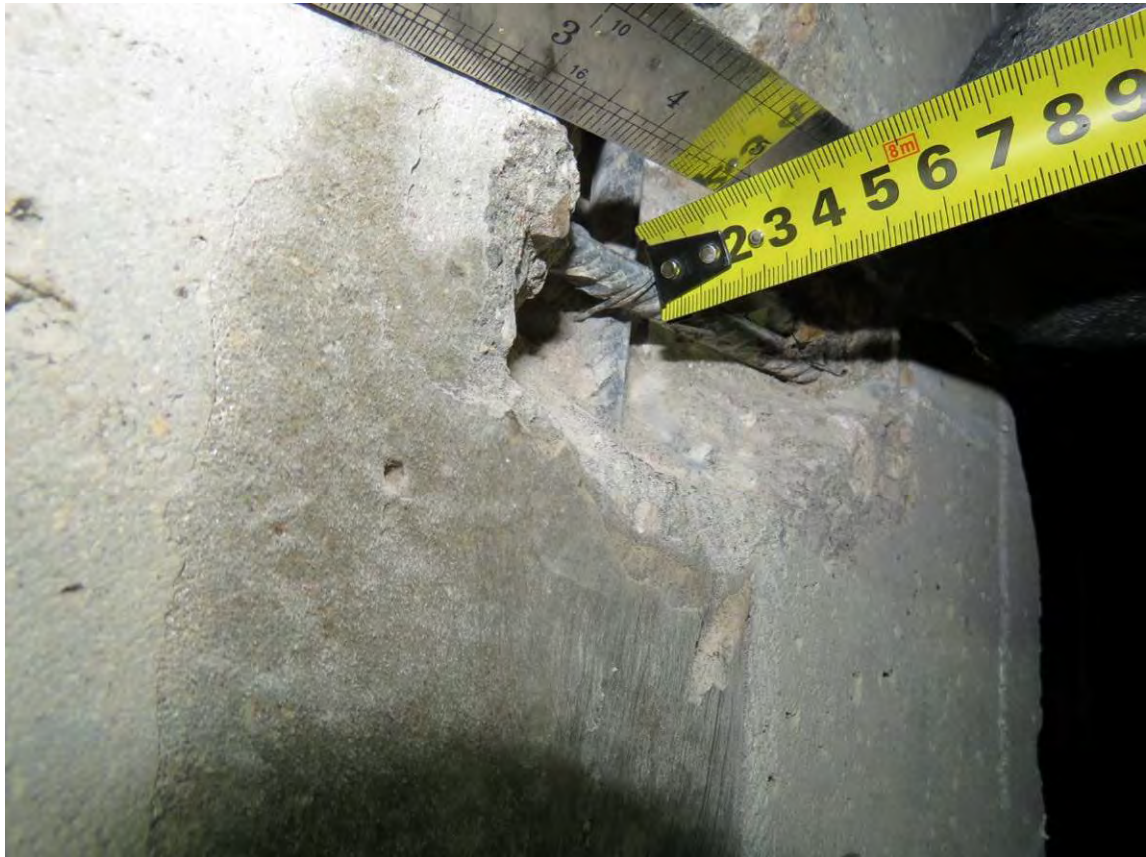
Рис. 3.2.5. Замер толщины защитного слоя бетона колонны на отм. -3,300 м
