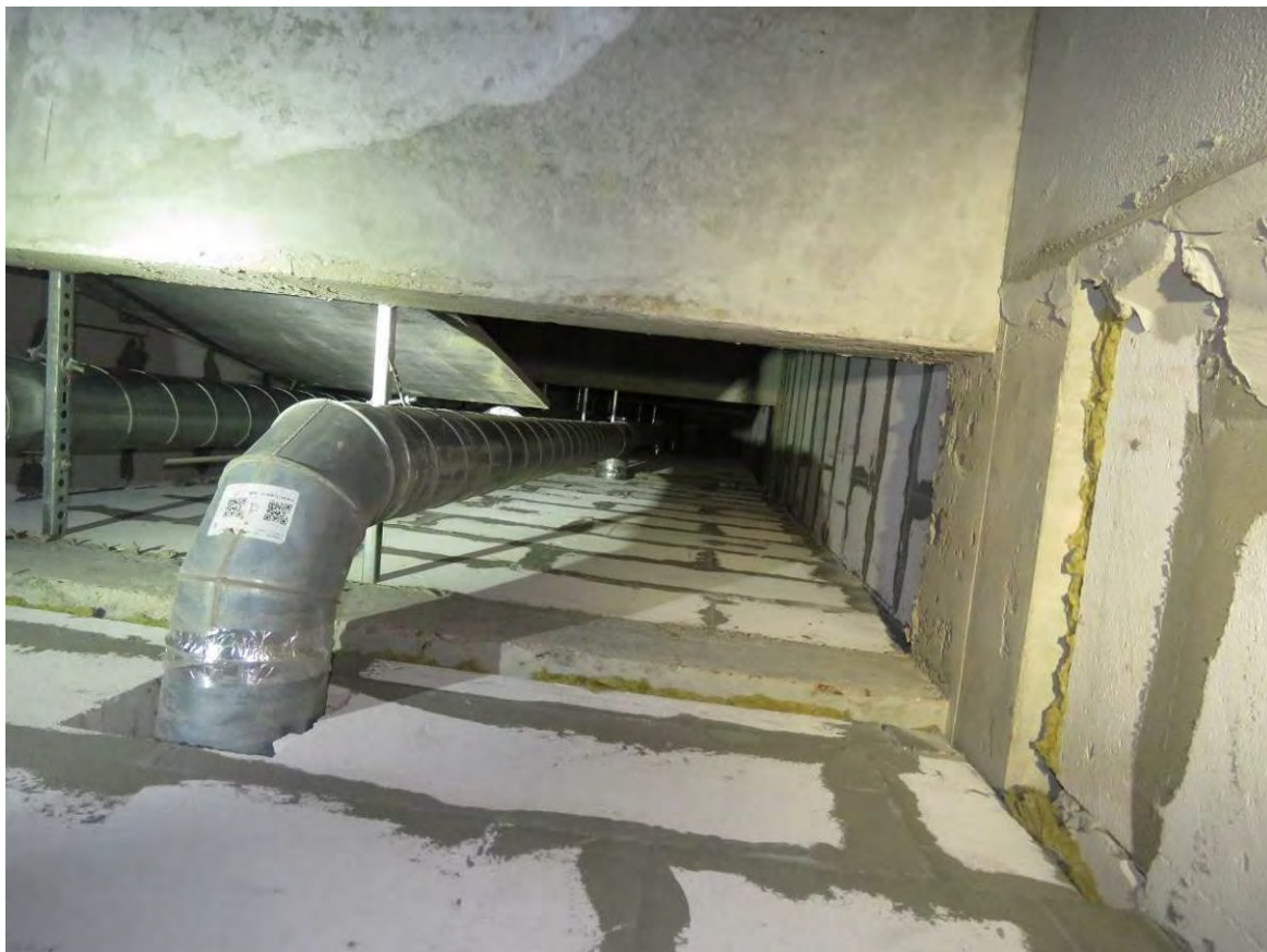
Рис.3.7.1.5. Общий вид смонтированного вентиляционного трубопровода
