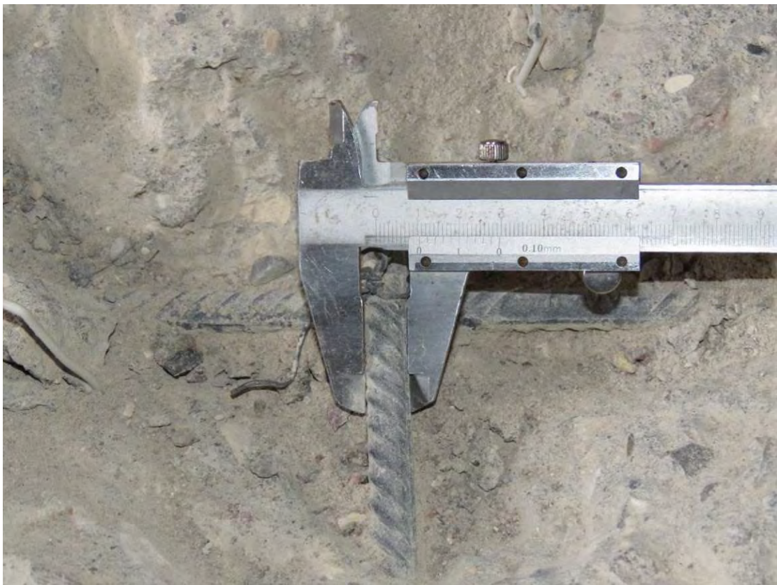
Рис. 3.3.8. Замер диаметра армирования плиты перекрытия
