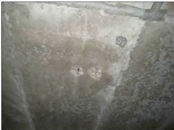
ФОТО 25. Общий вид вскрытия нижней зоны монолитной железобетонной плиты перекрытия третьего этажа жилого дома между осями Р/2-С/2 / 24/2-25/2.
