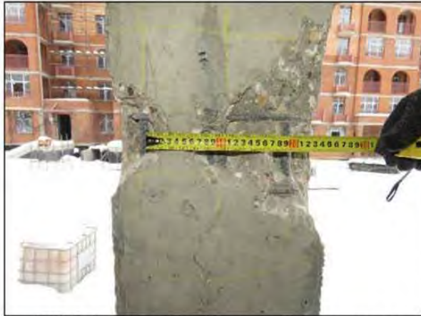
ФОТО 9. Общий вид вскрытия монолитной железобетонной колонны входной группы первого этажа жилого дома между осями А/2 / Г/2 и за осью 28/2.
