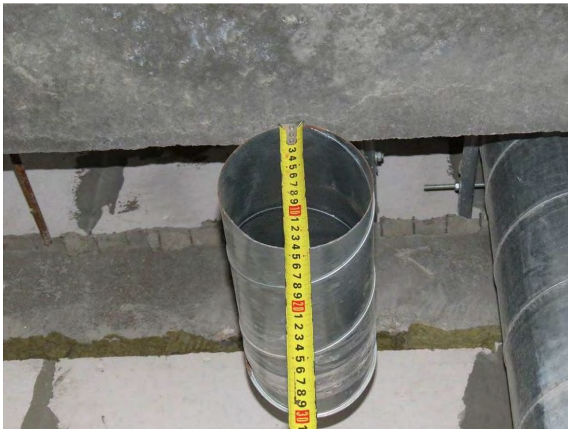
Рис.3.7.1.6. Замер диаметра трубопровода
