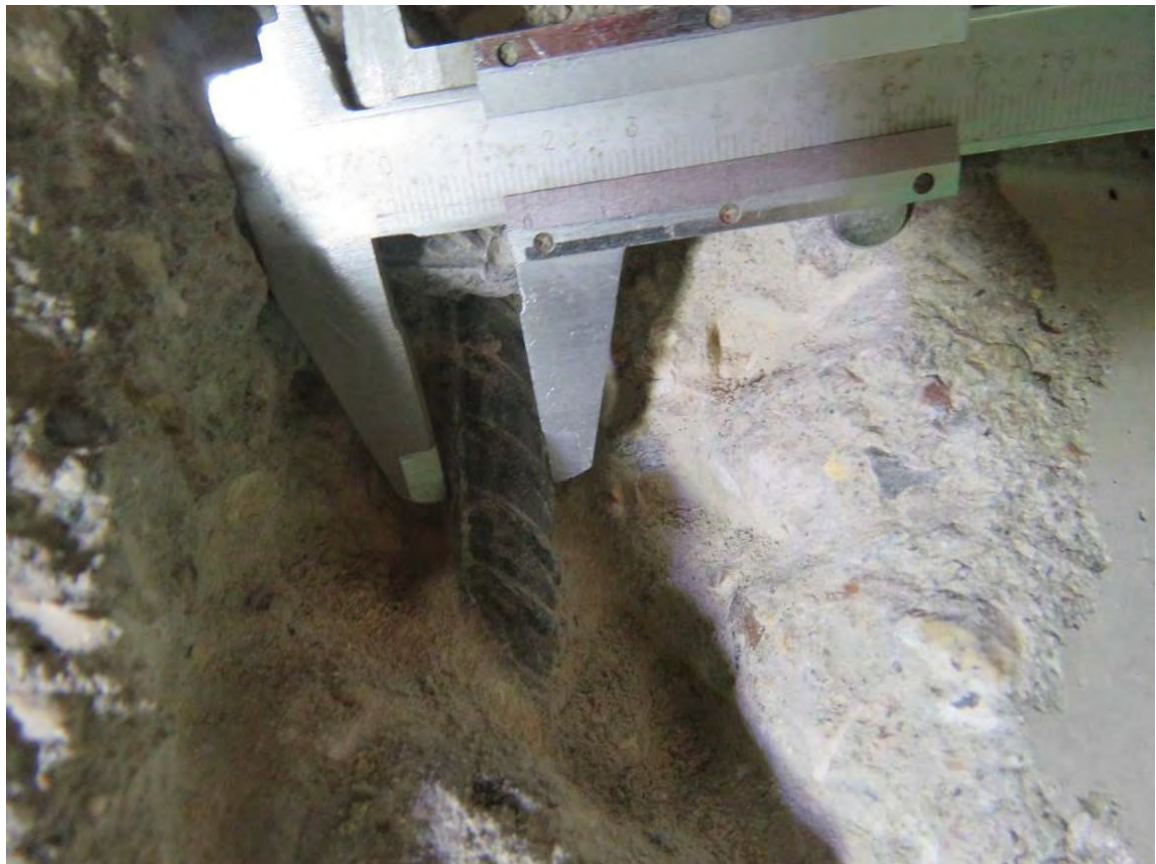
Рис. 3.2.4. Замер диаметра вертикального армирования пилона на отм. -3,300 м
