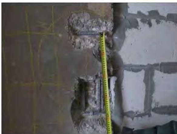
ФОТО 19. Общий вид вскрытия монолитного железобетонного пилона третьего этажа жилого дома между осями 27/2-28/2 и по оси Н/2.
