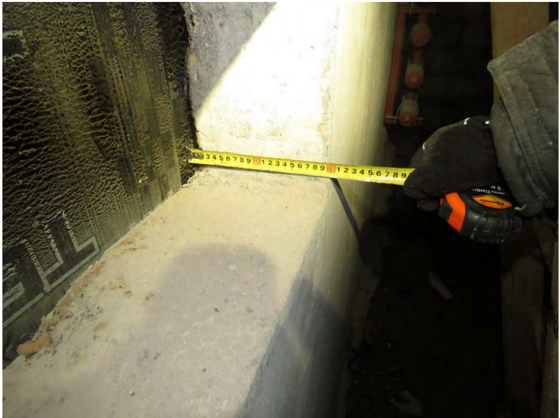
Рис. 3.2.2. Замер толщины наружной монолитной ж.б. стены
