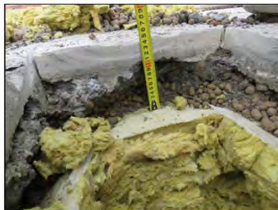
ФОТО 40. Уточнение высоты слоя кровли керамзитового гравия по оси «В/2» между осями «16/2»-«17/2».
