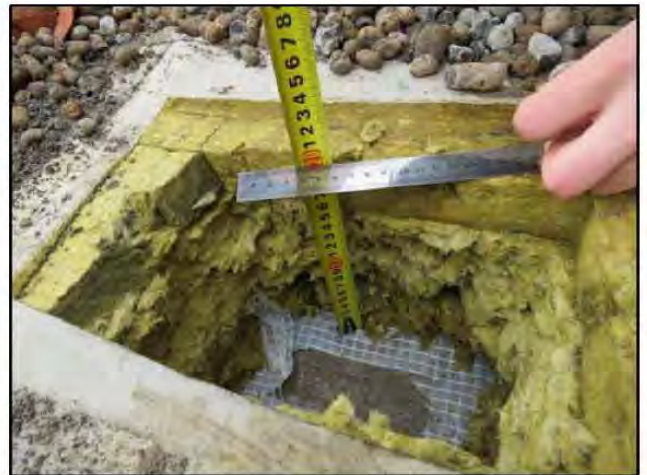
ФОТО 42. Уточнение высоты слоя кровли утеплителя минераловатными плитами между осями «Е/2»-«Ж/2» и «26/2»-«27/2».
