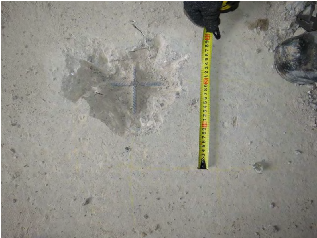
Рис. 3.3.7. Общий вид участка вскрытия монолитной ж.б. плиты перекрытия 6-го этажа между осями 16/2-17/2 и А/2-Г/2 (зона верхнего армирования)
