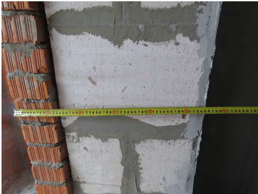
Рис. 3.4.2. Замер толщины наружной стены жилого дома (тип 1)
