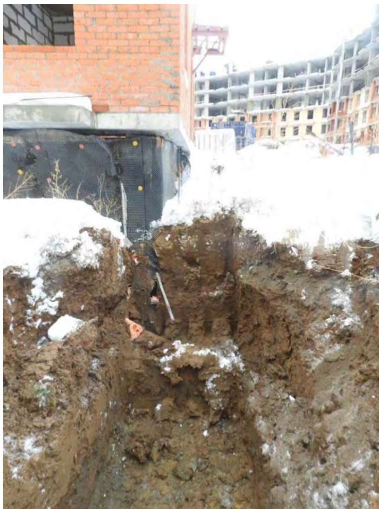
Рис. 3.1.2. Шурф №2 под наружную несущую монолитную ж.б. стену снаружи здания секция 4 на пересечении осей 29/2 и Т/2
