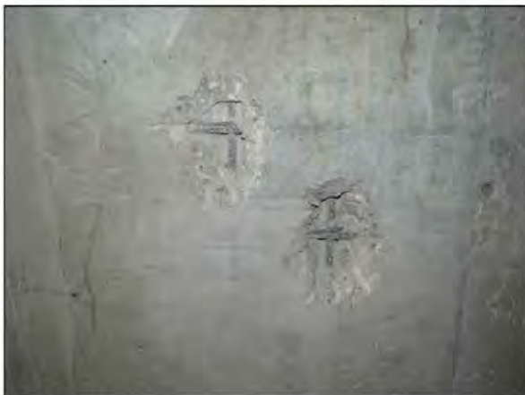
ФОТО 37. Общий вид вскрытия монолитной железобетонной стены седьмого этажа жилого дома между осями Д/2-И/2 и по оси 19/2.
