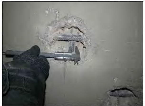
ФОТО 32. Уточнение диаметра рабочей арматуры монолитного железобетонного пилона седьмого этажа жилого дома между осями А/2-Г/2 и 19/2-20/2.
