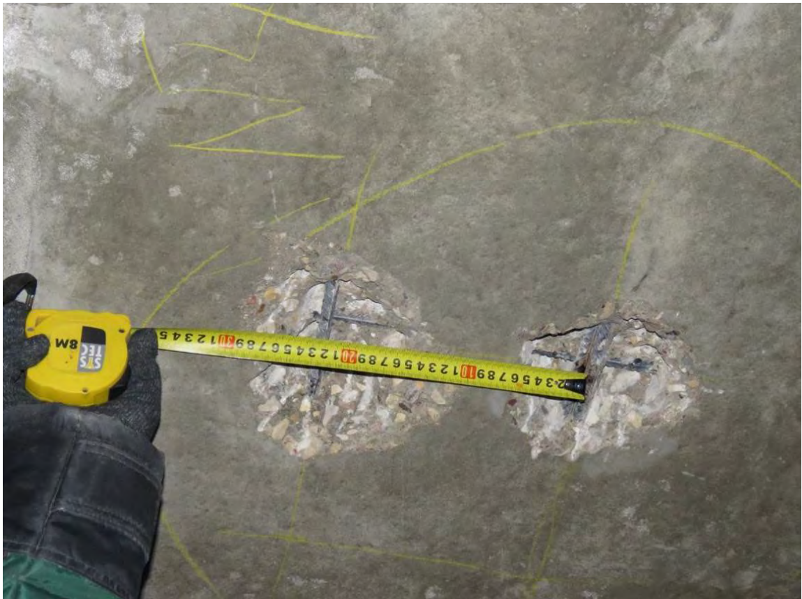
Рис. 3.3.6. Общий вид участка вскрытия монолитной ж.б. плиты перекрытия 3-го этажа между осями 24/2-25/2 и Р/2-С/2 (зона нижнего армирования)
