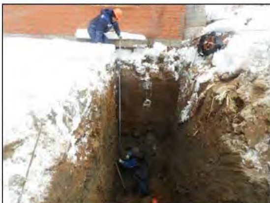
ФОТО 1 Общий вид внутреннего пространства шурфа №1 расположенного на пересечении осей 1/2 и Б/2.
