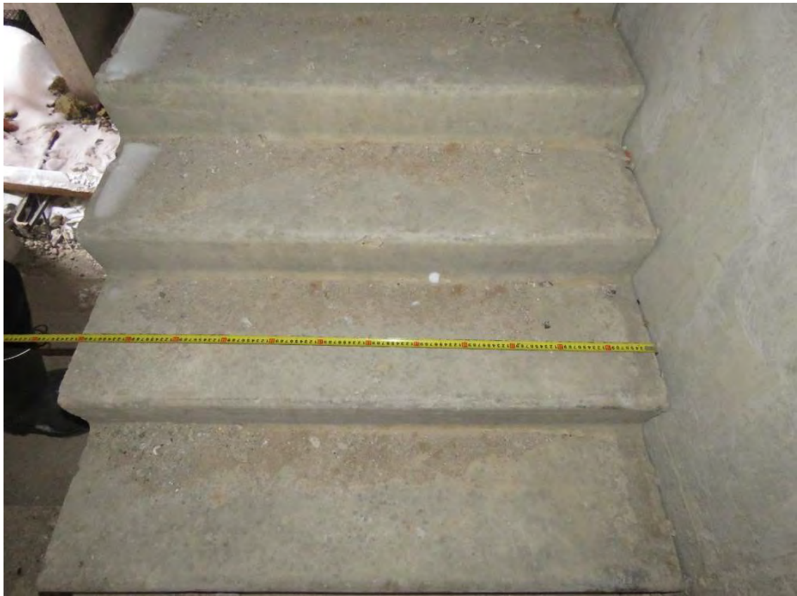
Рис. 3.5.3. Уточнение ширины марша двухмаршевой лестничной конструкции
