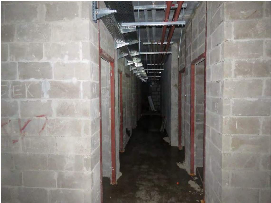
Рис. 1.6. Общий вид внутреннего пространства подвального этажа секции №4 между осями 25/2-26/2, С/2-М/2
