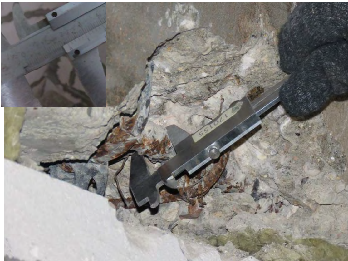
Рис. 3.3.11. Общий вид участка вскрытия монолитной ж.б. балки плиты перекрытия третьего этажа по оси Н/2 между осями 26/2-28/2
