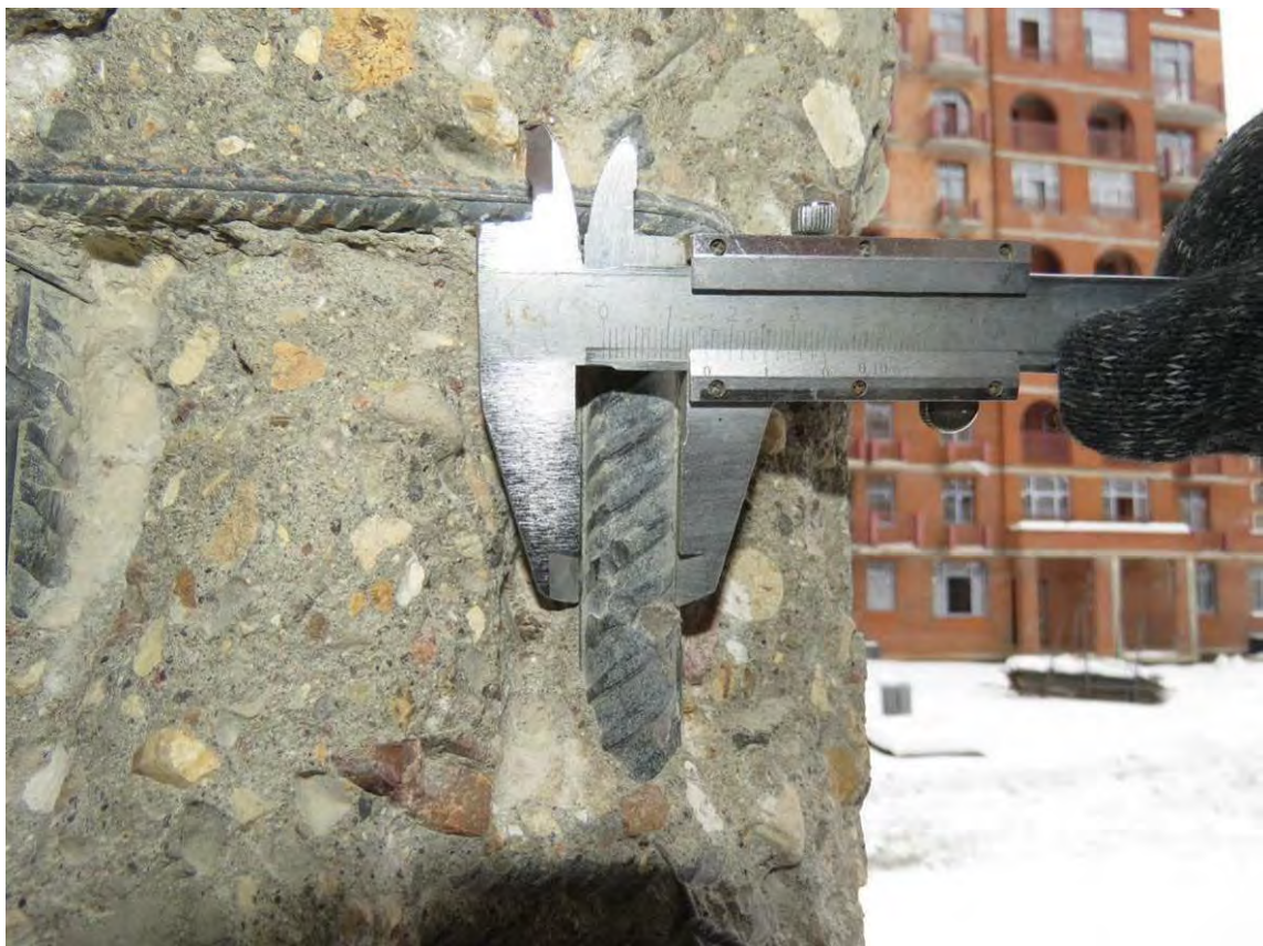
Рис. 3.2.6. Замер диаметра вертикального армирования колонны на отм. ±0,000 м
