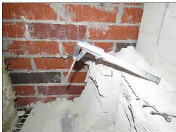
ФОТО 24. Уточнение диаметра гибких связей ограждающих конструкций третьего этажа жилого дома по осям T/2 / 29/2.
