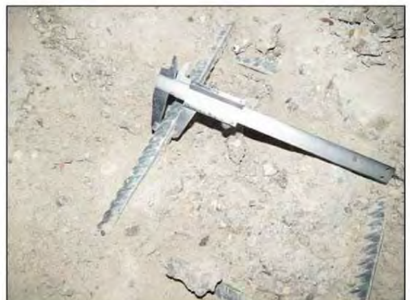
ФОТО 4. Уточнение диаметра рабочей арматуры монолитного железобетонного фундамента жилого дома между осями А/2-Г/2 / 27/2-28/2.
