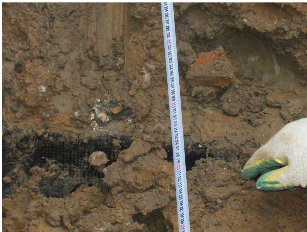
Рис. 3.1.12 (а, б, в) Отсутствие дренажной мембраны типа «Дрениз» на монолитной железобетонной фундаментной плите в отрытом шурфе №1, №2, а также на отдельных участках по периметру здания в местах отсутствия обратной засыпке
