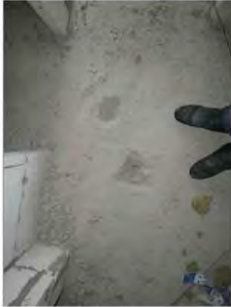
ФОТО 1. Общий вид вскрытия верхней зоны монолитной железобетонной плиты перекрытия подвала жилого дома между осями А/2-Г/2 / 24/2-25/2.
