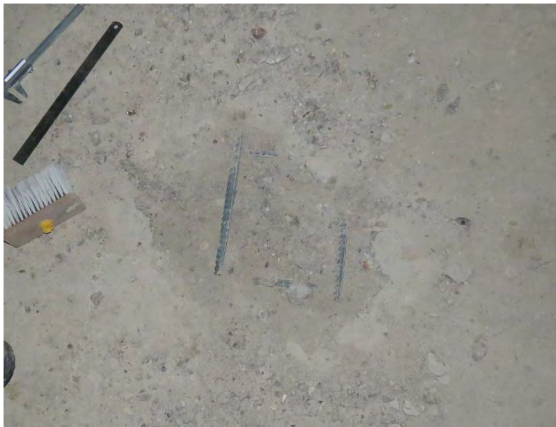
Рис. 3.1.6.Общий вид вскрытия фундаментной плиты в секции 4 между осями Г/2 – А/2, 27/2-28/2
