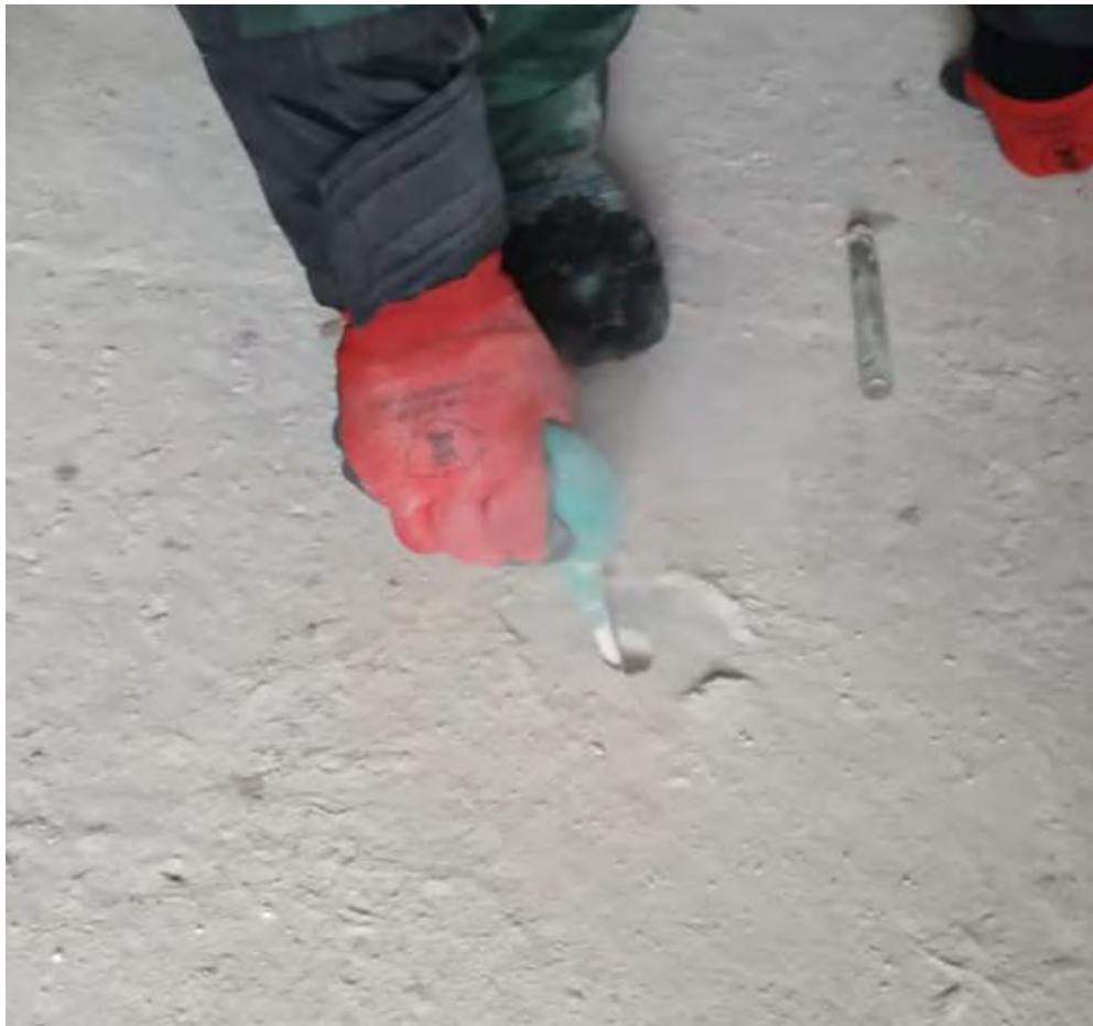
Рис. 4.2.3. Зачистка отверстия
