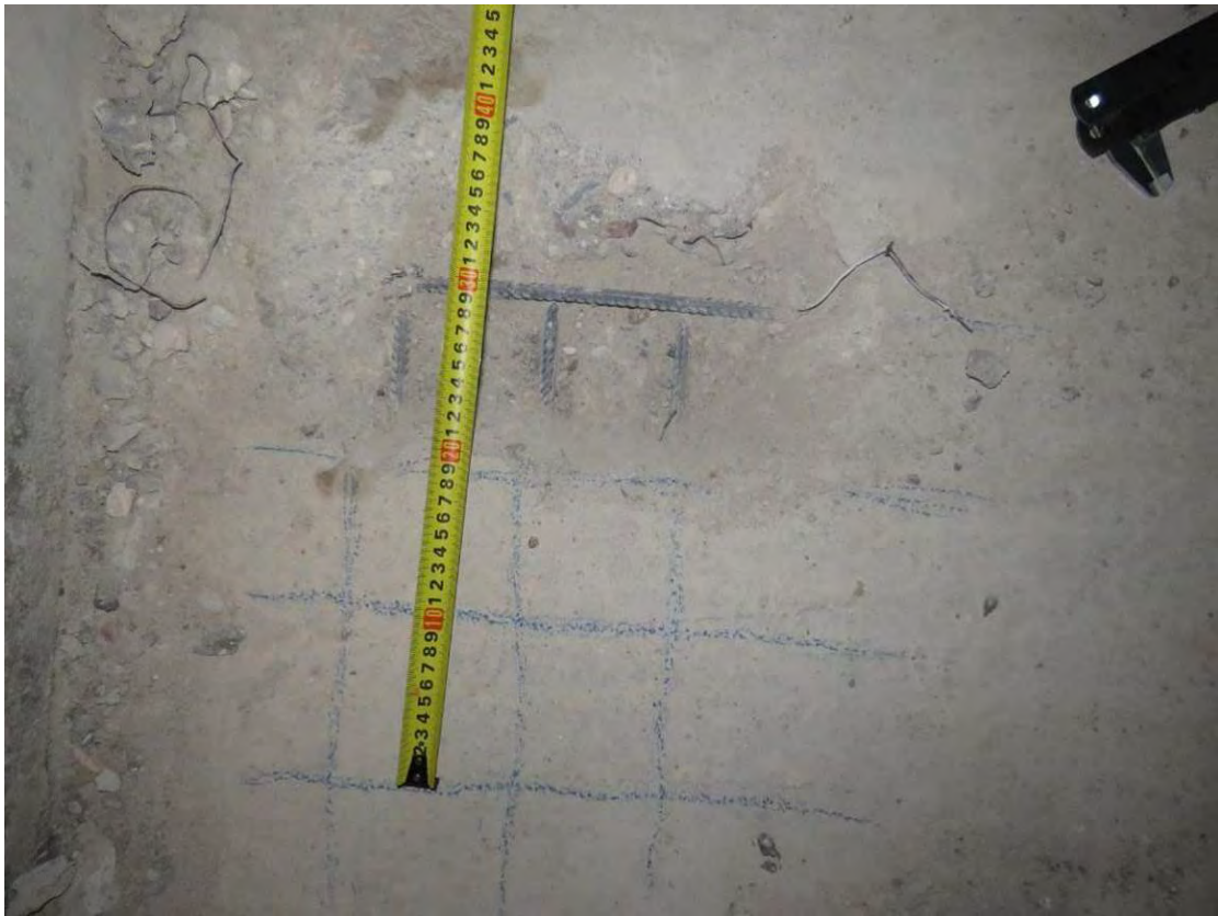
Рис. 3.3.5. Общий вид участка вскрытия монолитной ж.б. плиты перекрытия 6-го этажа в зоне пилона по оси 20/2 между осями А/2-Г/2 (зона верхнего армирования)
