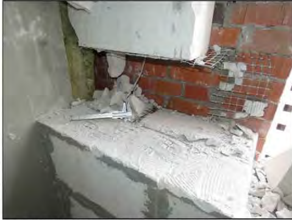
ФОТО 29. Общий вид вскрытия ограждающих конструкций седьмого этажа жилого дома по оси Б/2 и между осями 16/2-17/2.
