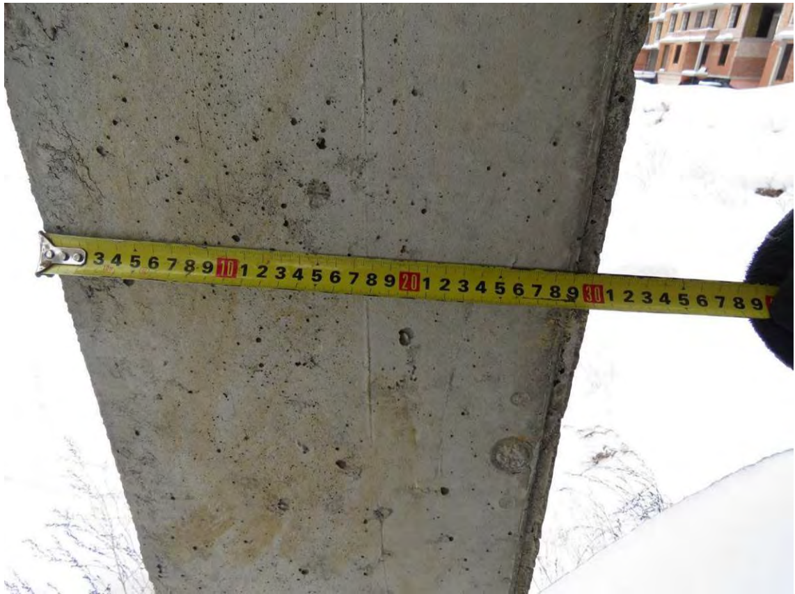
Рис. 3.2.3. Замер сечения монолитной ж.б. колонны входной группы на отм. \pm 0,000 м
