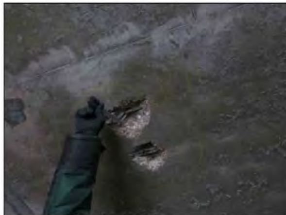
ФОТО 26. Уточнение диаметра рабочей арматуры монолитной железобетонной плиты перекрытия третьего этажа жилого дома между осями Р/2-С/2 / 24/2-25/2.
