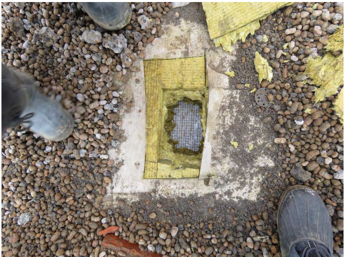
Рис. 3.6.2. Общий вид участка вскрытия кровли между осями Е/2-Ж/2 и 26/2-27/2
