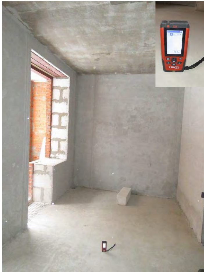
Рис. 2.3. Замер высоты помещений типового этажа при помощи лазерного дальномера HILTI PD-1
