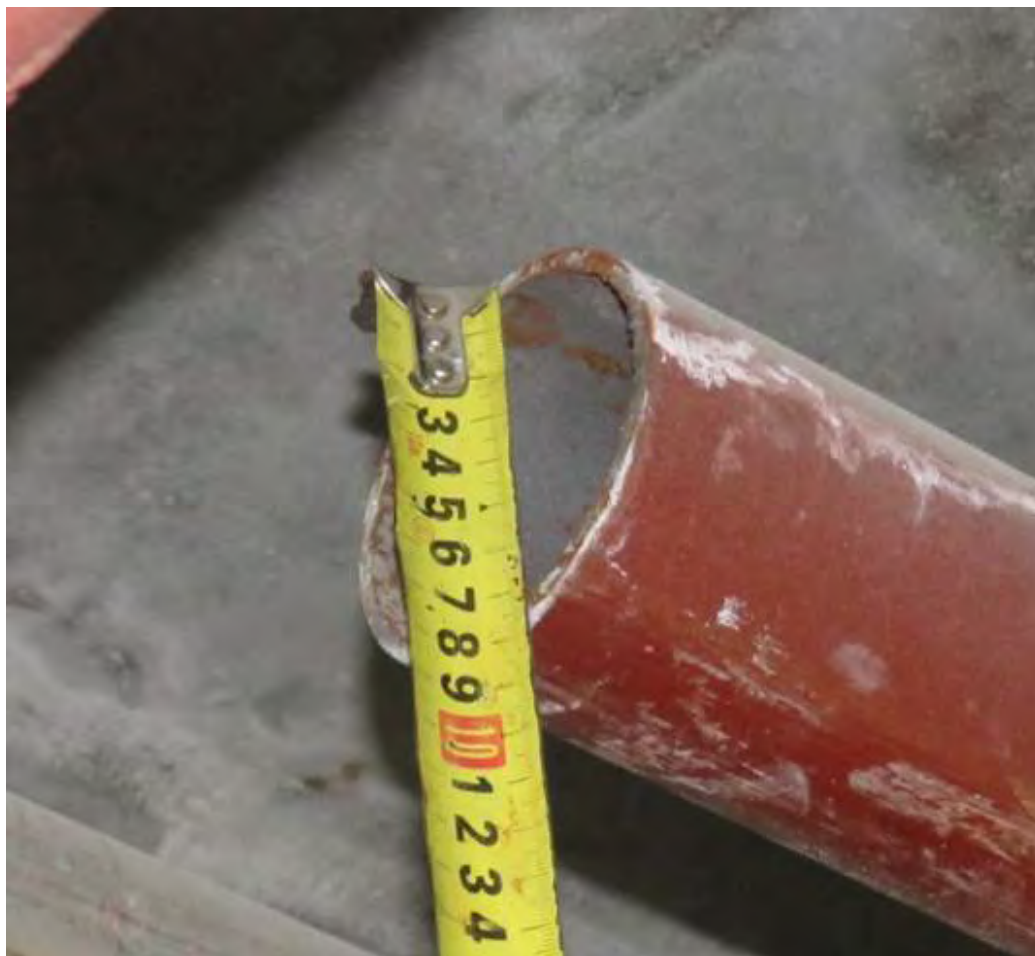
Рис.3.7.1.2. Замер диаметра трубопровода системы теплоснабжения
