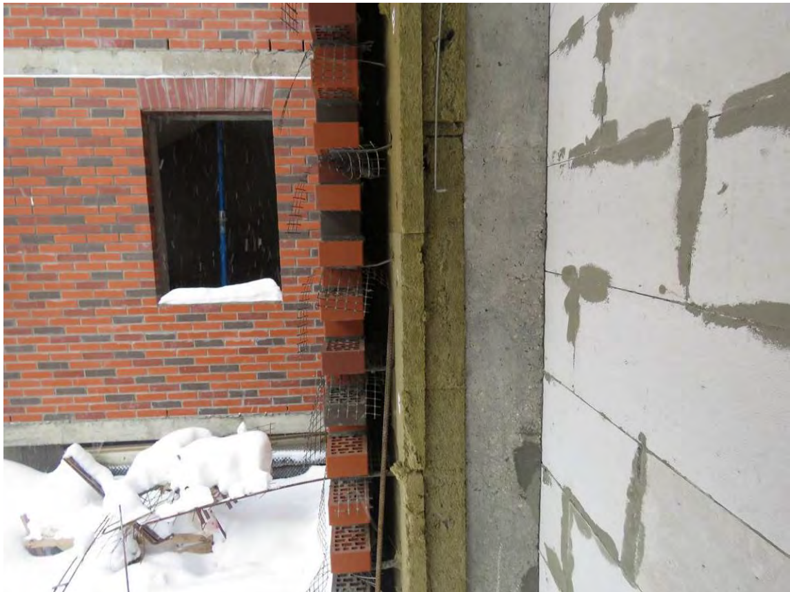
Рис. 3.4.4. Общий вид наружных стен жилого дома (тип 2)
