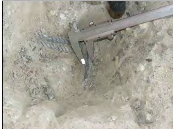
ФОТО 6. Уточнение диаметра рабочей арматуры монолитной железобетонной плиты перекрытия подвала жилого дома между осями 27/2-28/2 и за осью А/2.
