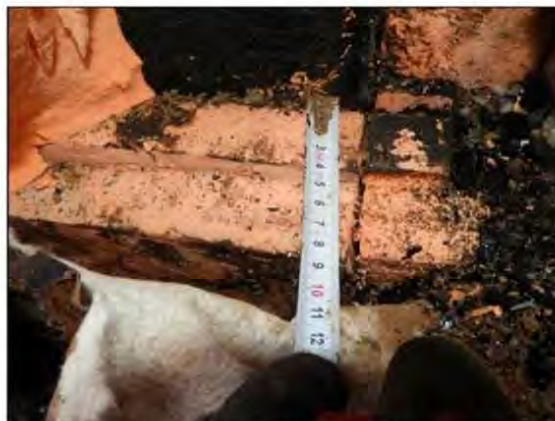
ФОТО 6. Уточнение ширины утеплителя наружной стены подвала расположенной на пересечении T/2 и 29/2.
