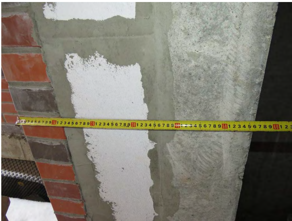
Рис. 3.4.7. Замер толщины наружной стены в зоне лестничных клеток (тип 3)
