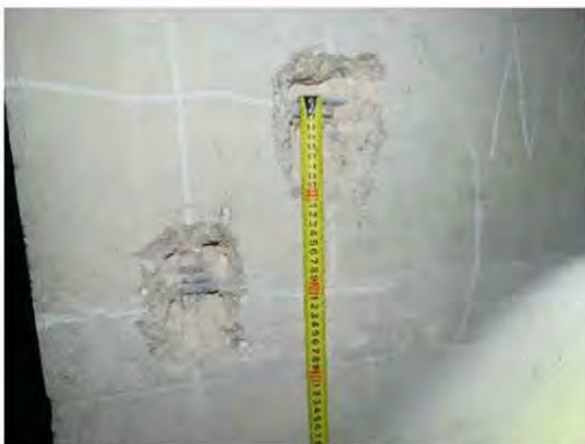
ФОТО 11. Общий вид вскрытия монолитного железобетонного пилона подвала жилого дома по оси Н/2 и между осями 27/2-28/2 .
