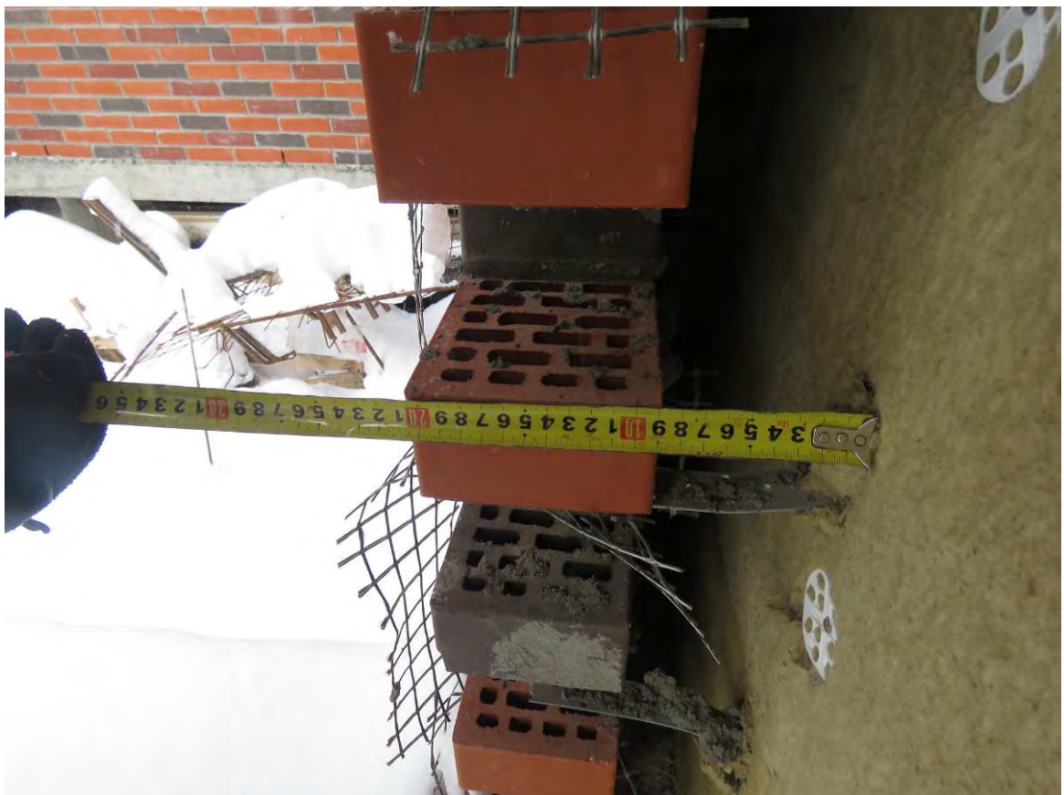
Рис. 3.4.6. Замер толщины воздушного зазора наружной стены жилого дома (тип 2)
