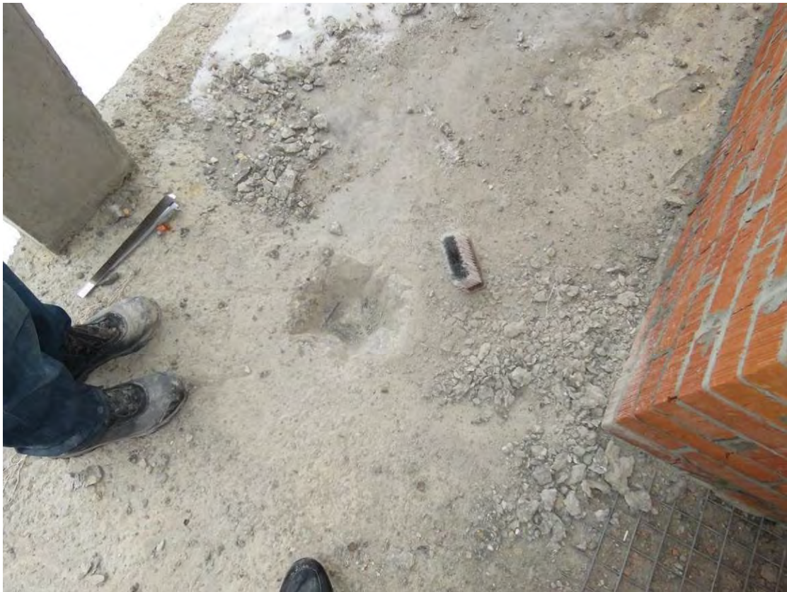
Рис. 3.3.9. Общий вид участка вскрытия монолитной ж.б. плиты перекрытия подвала по оси А/2 между осями 27/2-28/2 (зона верхнего армирования)
