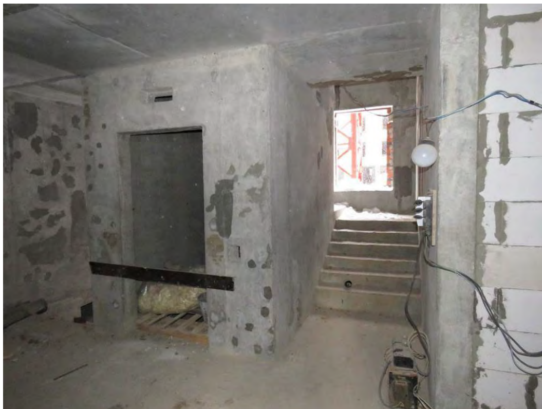
Рис. 3.5.2. Общий вид лестничной клетки (одномаршевой лестницы) расположенной в уровне первого этажа
