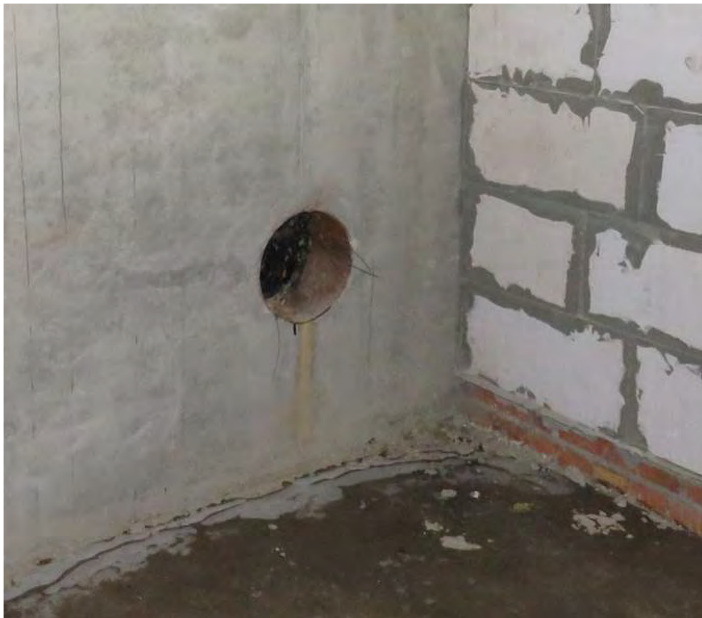
Рис. 3.1.10 (а, б) Фильтрация воды в подвальное помещение в местах прохода коммуникаций
