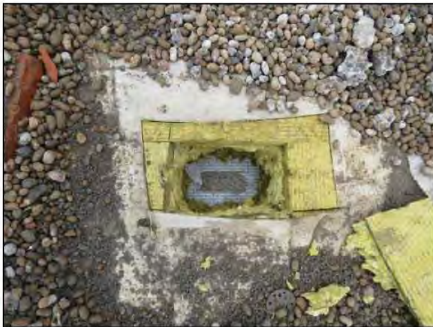
ФОТО 41. Общий вид вскрытия кровельного пирога между осями «Е/2»-«Ж/2» и «26/2»-«27/2».
