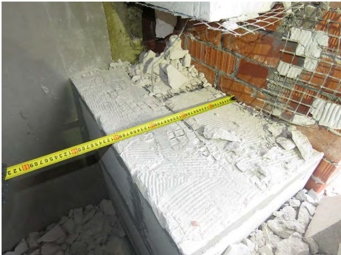
Рис. 3.4.10. Замер толщины внутреннего слоя из газобетонных блоков в ограждающей конструкции наружных стен примыкающих к пилону в уровне 7-го этажа на пересечении осей А/2, 17/2
