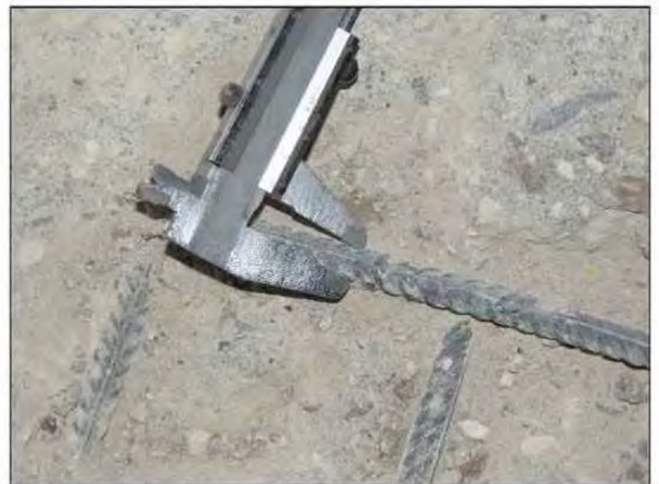
ФОТО 36. Уточнение диаметра рабочей арматуры монолитной железобетонной плиты пола седьмого этажа жилого дома между осями А/2-Г/2 / 20/2-21/2.
