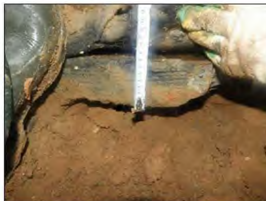
ФОТО 3. Уточнение высоты подбетонки фундаментной плиты расположенной на пересечении 1/2 и Б/2.
