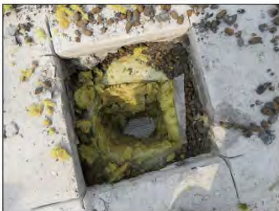
ФОТО 39. Общий вид вскрытия кровельного пирога по оси «В/2» между осями «16/2»-«17/2».
