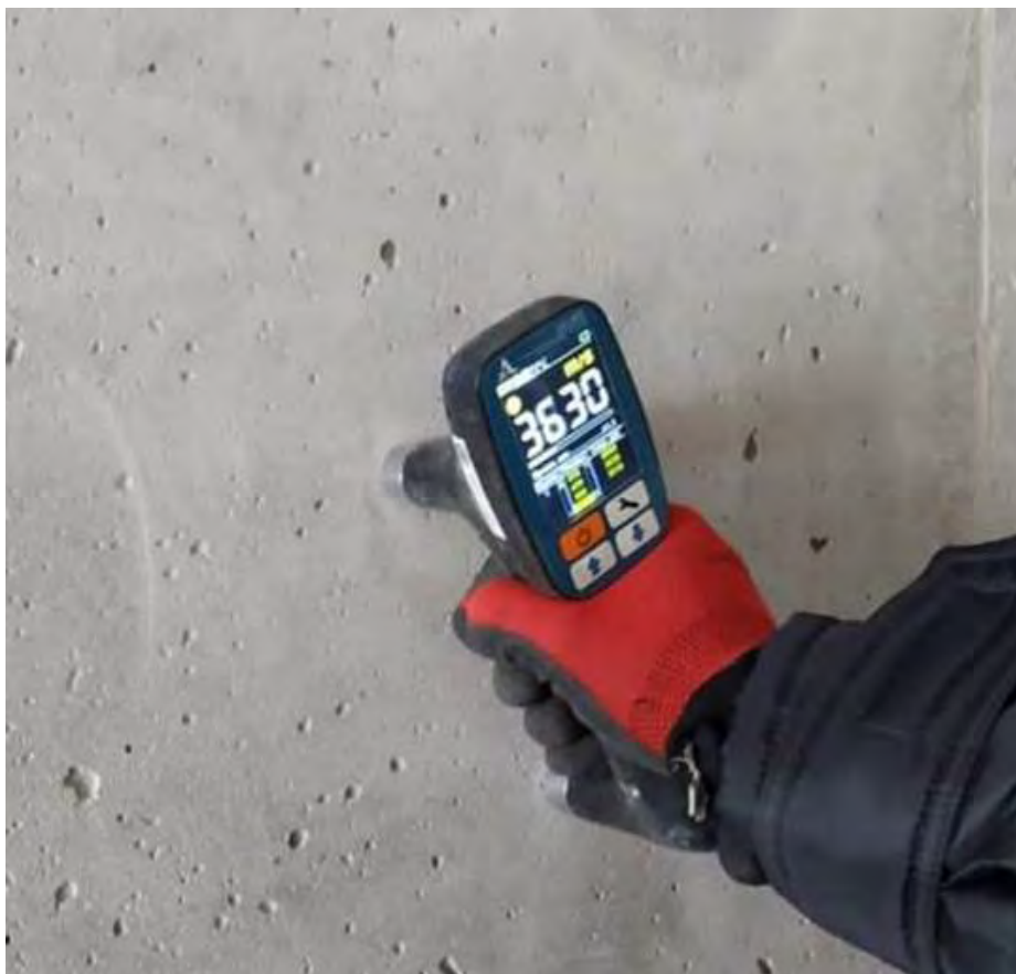
Рис. 4.3.2. Определение прочности бетона ультразвуковым методом прибором «УК 1401»
