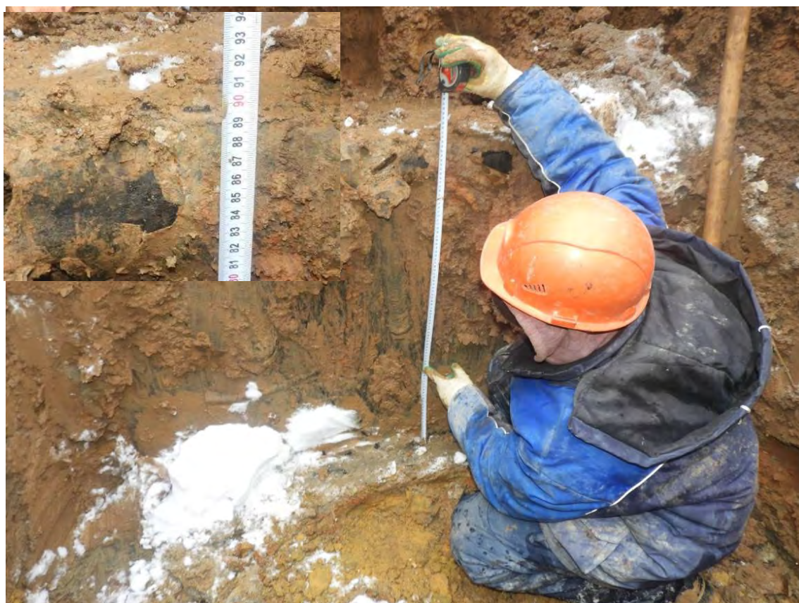
Рис. 3.1.4. Замер толщины фундаментной плиты в отрытом шурфе №2 секции 4 на пересечении осей 29/2 и Т/2
