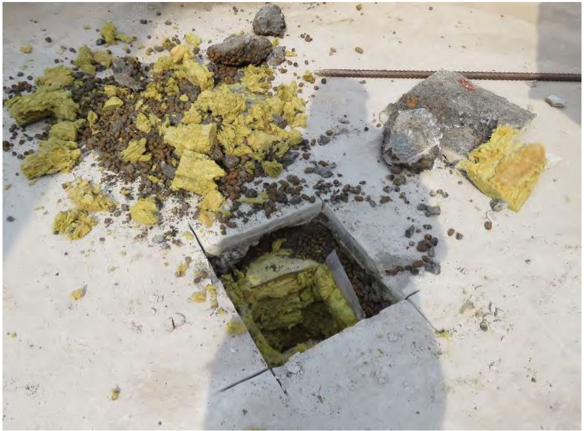
Рис. 3.6.5. Общий вид участка вскрытия кровли между осями Б/2-В/2 и 16/2-17/2
