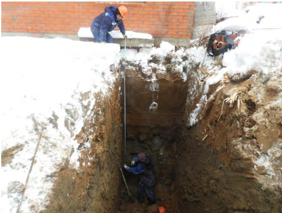
Рис. 3.1.1. Шурф №1 под наружную несущую монолитную ж.б. стену снаружи здания секция 1 на пересечении осей Б/2 и 1/2
