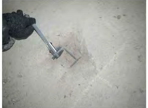
ФОТО 2. Уточнение диаметра рабочей арматуры монолитной железобетонной плиты перекрытия подвала жилого дома между осями А/2-Г/2 / 24/2-25/2.
