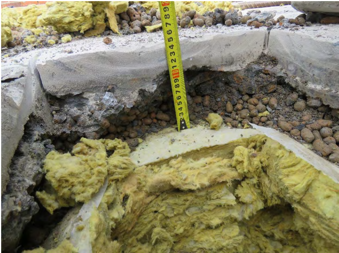
Рис. 3.6.7. Замер толщины стяжки и разуклонки из керамзитового гравия
