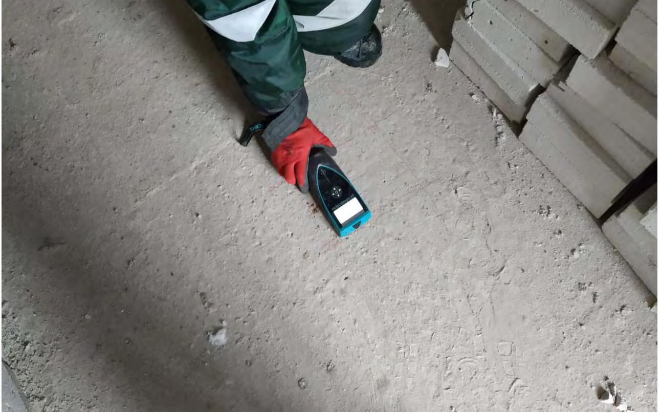
Рис. 4.4.1. Построение карты арматурной сетки с использованием прибора Proceq Profoscope
