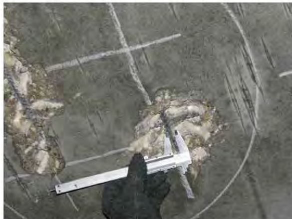
ФОТО 14. Уточнение диаметра рабочей арматуры монолитной железобетонной плиты перекрытия подвала жилого дома между осями Р/2-С/2 / 27/2-28/1.
