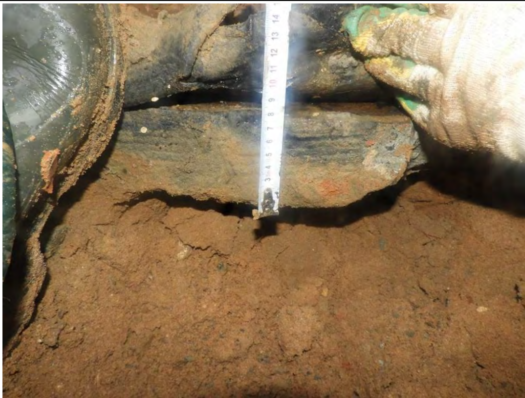
Рис. 3.1.5. Замер толщины бетонной подготовки в отрытом шурфе №1 секции 1 на пересечении осей Б/2 и 1/2
