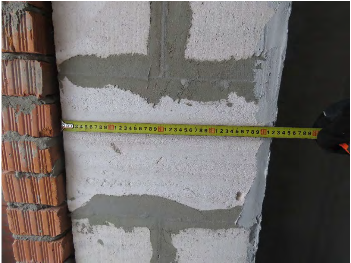
Рис. 3.4.3. Замер толщины внутреннего слоя наружных стен жилого дома (тип 1)
