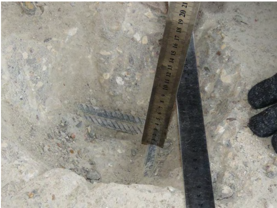
Рис. 3.3.10. Замер толщины защитного слоя бетона верхнего армирования плиты перекрытия подвала по оси А/2 между осями 27/2-28/2
