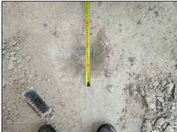
ФОТО 5. Общий вид вскрытия верхней зоны монолитной железобетонной плиты перекрытия подвала жилого дома между осями 27/2-28/2 и за осью А/2.
