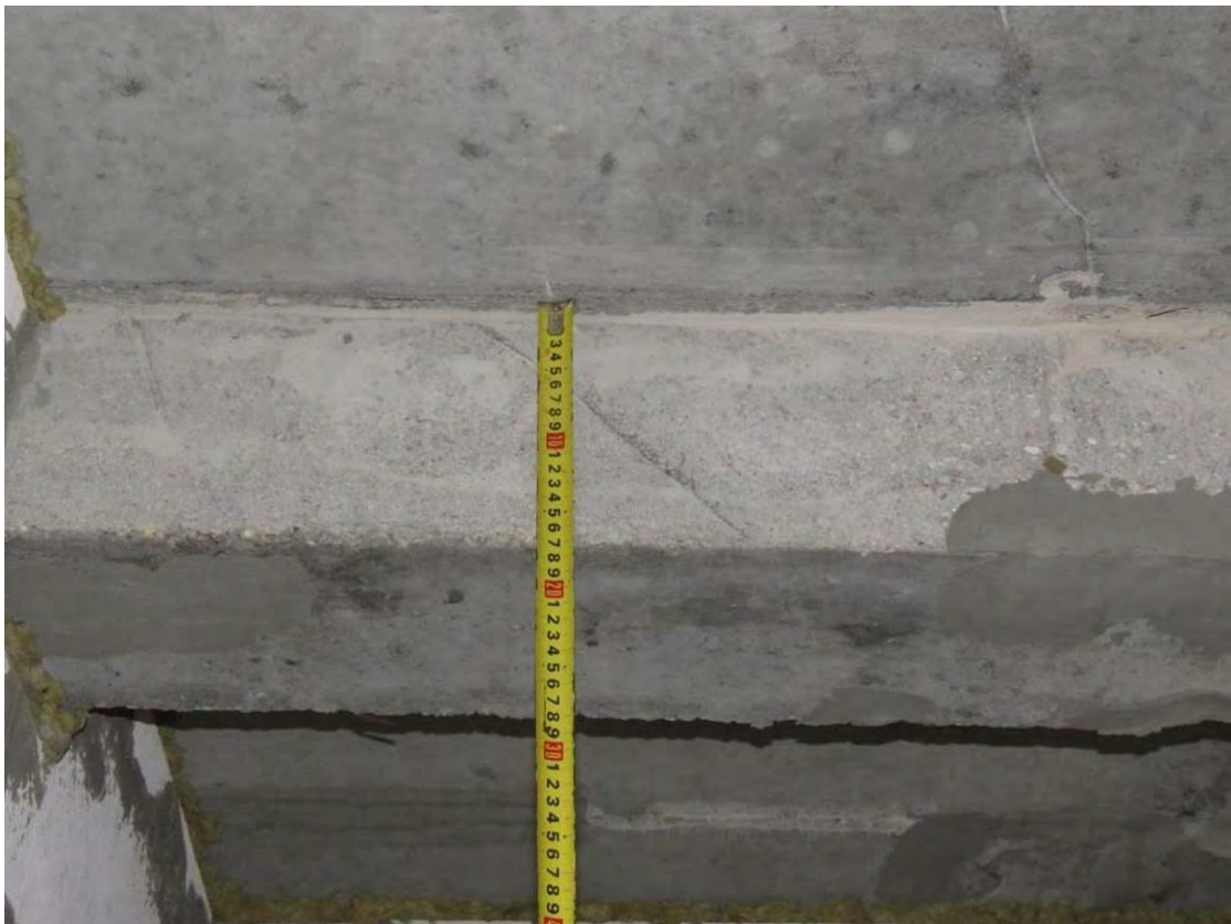
Рис. 3.3.4. Замер сечения монолитной ж.б. балки перекрытия
