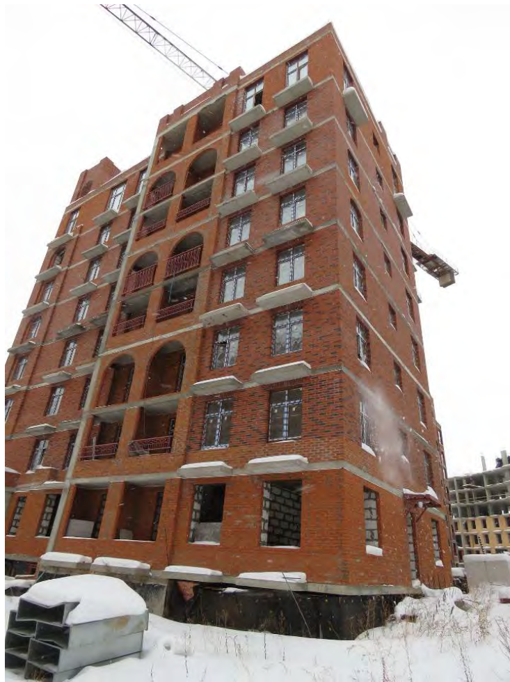
Рис. 3.4.1. Общий вид ограждающих конструкций наружных стен жилого дома
