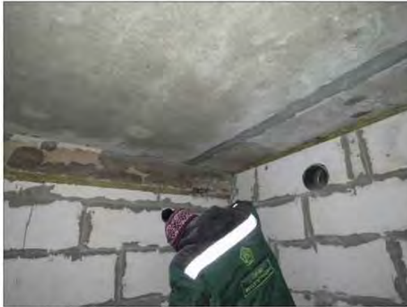
ФОТО 17. Общий вид вскрытия монолитной железобетонной балки третьего этажа жилого дома по оси Н/2 и между осями 27/2 -28/2.
