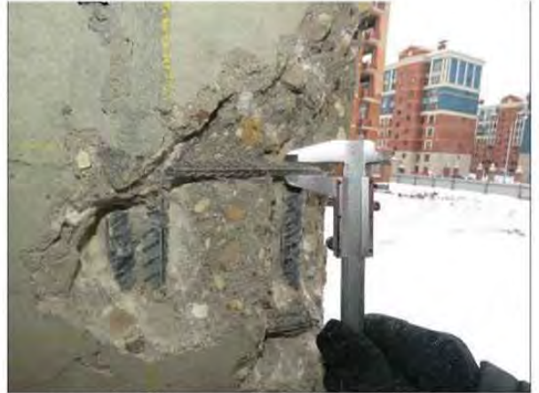
ФОТО 10. Уточнение диаметра рабочей арматуры монолитной железобетонной колонны входной группы первого этажа жилого дома между осями А/2 / Г/2 и за осью 28/2.
