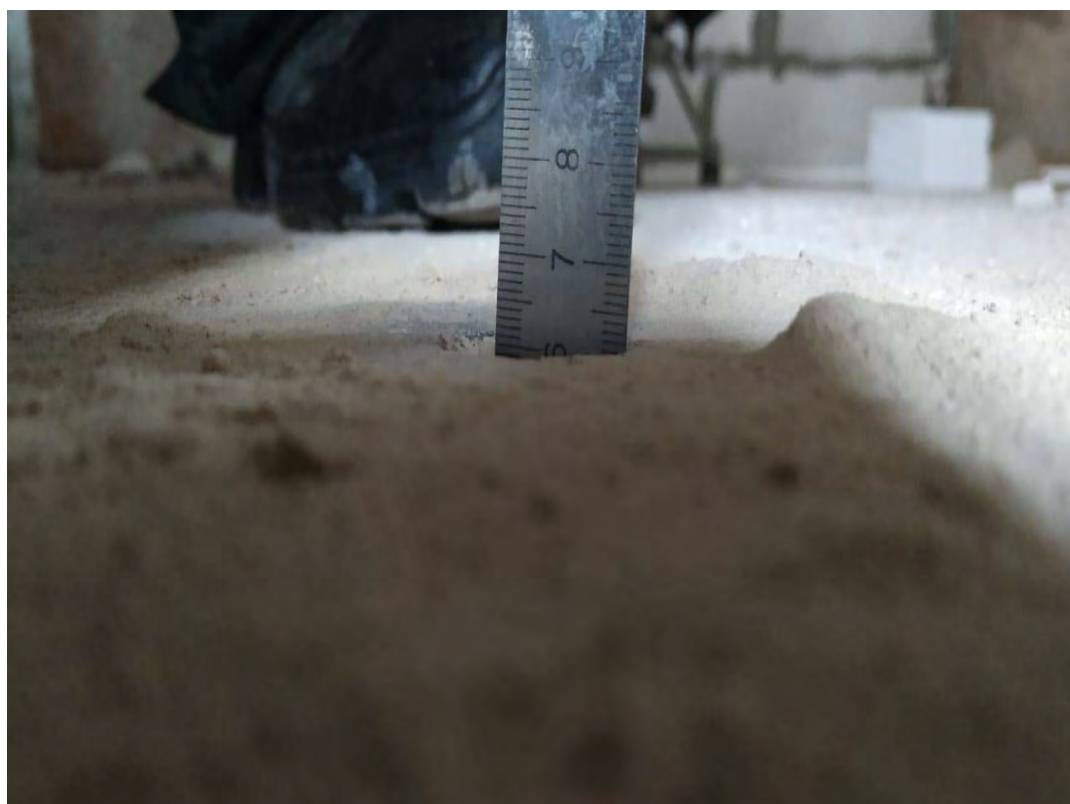
Рис. 4.2.2. Замер глубины отверстия
