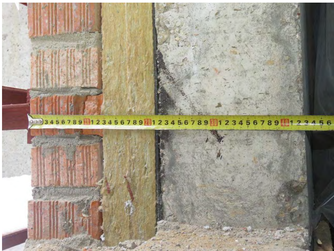
Рис. 3.4.8. Замер толщины наружной стены подвала
