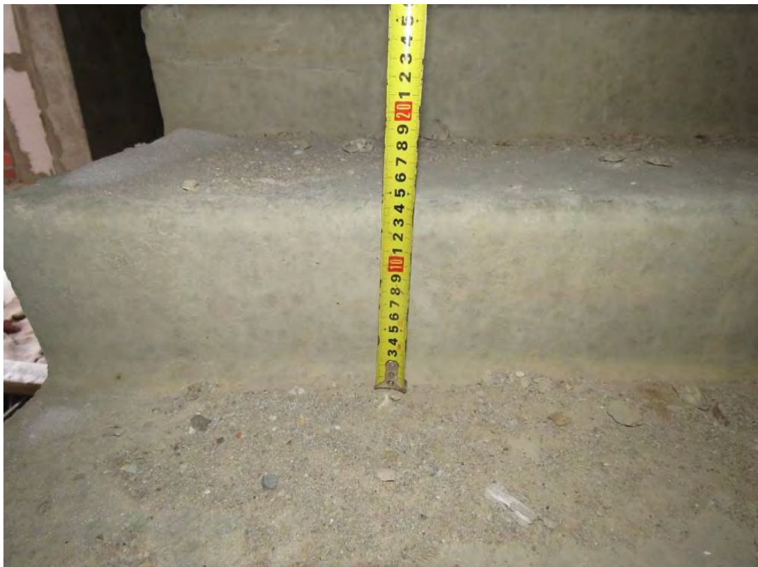
Рис. 3.5.4. Уточнение высоты подступенка двухмаршевой лестничной конструкции
