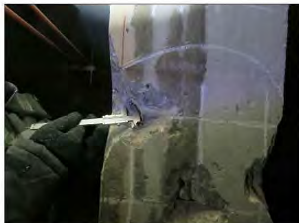
ФОТО 16. Уточнение диаметра рабочей арматуры монолитной железобетонной колонны подвала жилого дома между осями Б/2-В/2 / 10/2-11/2.
