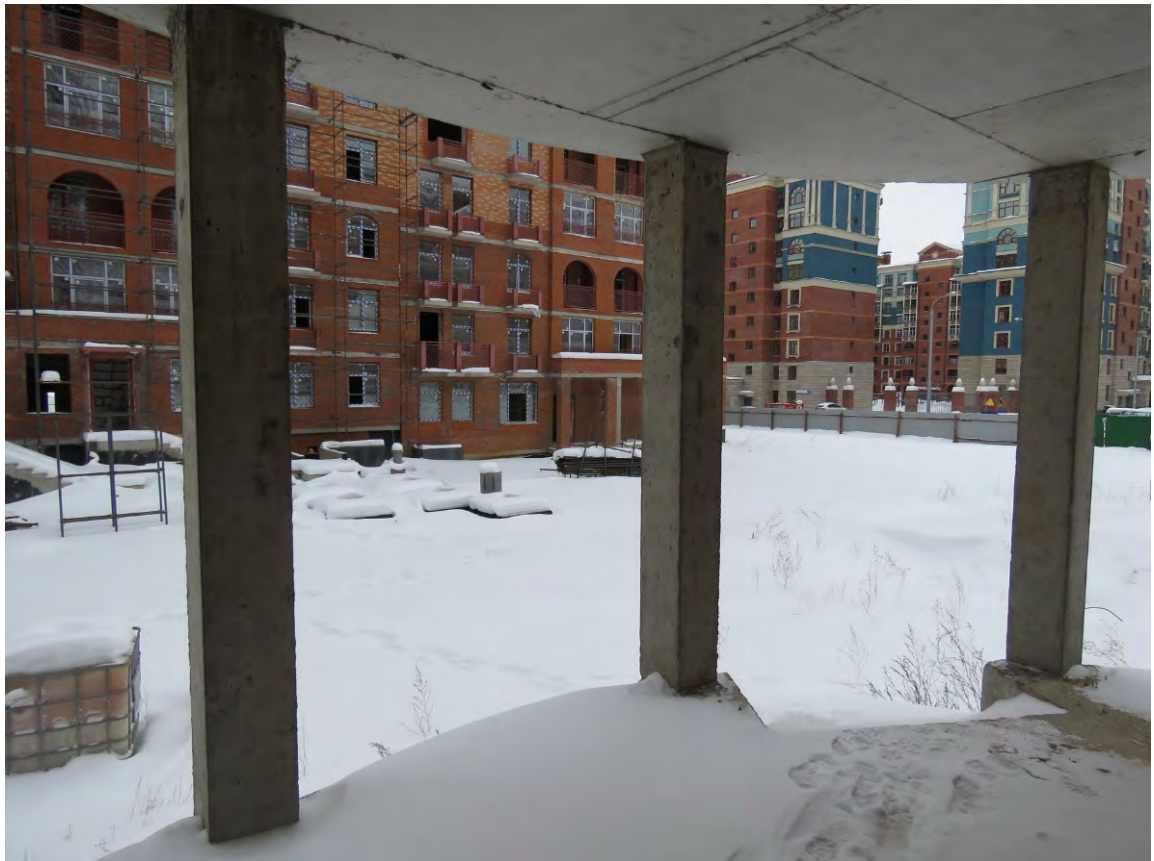
Рис. 3.2.1. Общий вид монолитных ж.б. колонн на отм ±0,000 м
