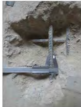
ФОТО 22. Уточнение диаметра рабочей арматуры монолитной железобетонной плиты пола третьего этажа жилого дома между осями P/2-C/2 / 27/2-28/2 .
