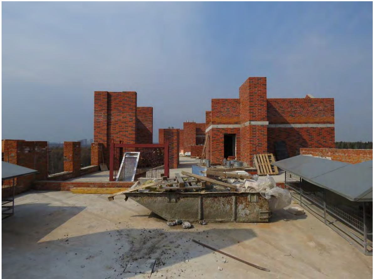
Рис. 3.6.1. Общий вид на кровлю здания
