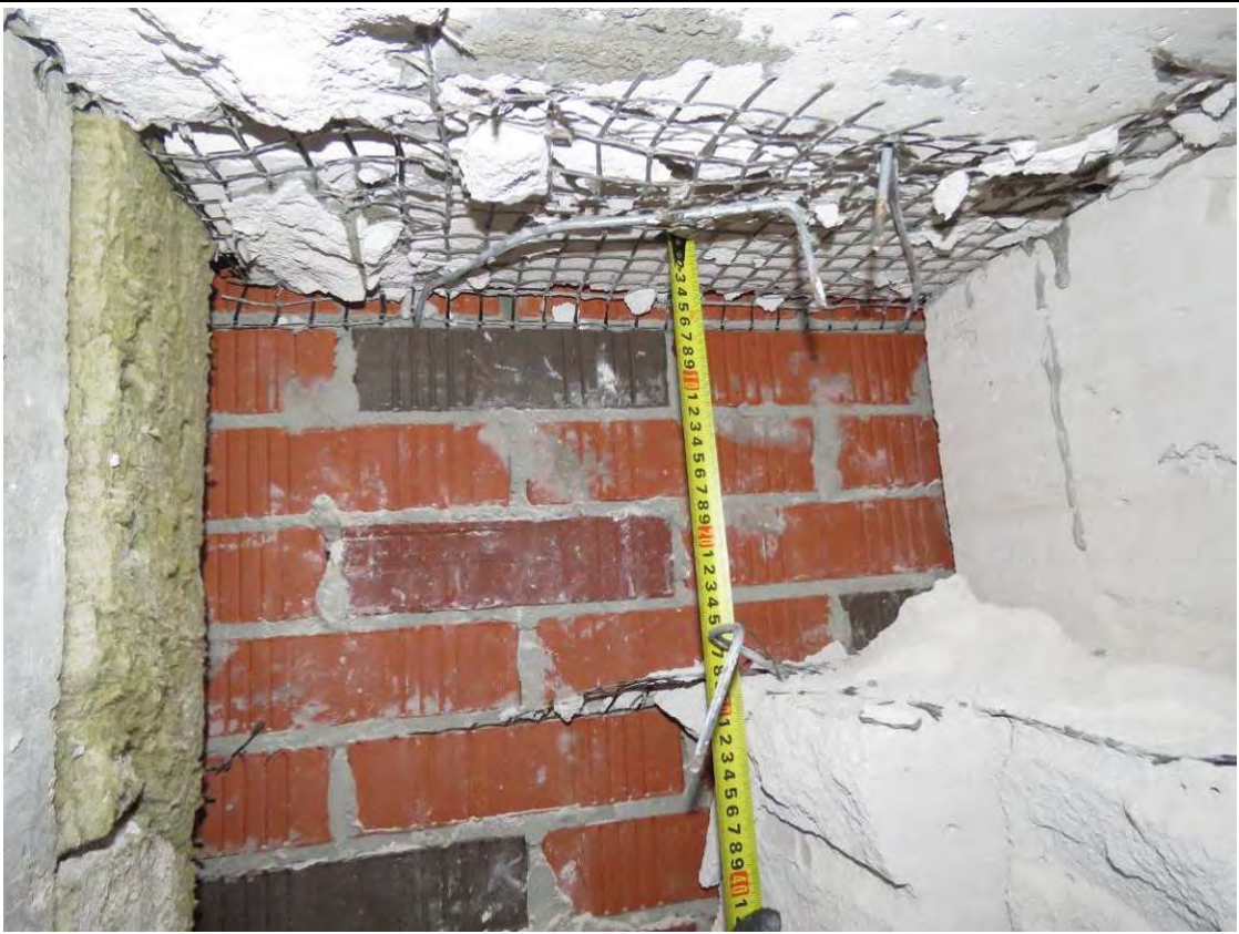
Рис. 3.4.13. Замер шага армирования и гибких связей по высоте в ограждающей конструкции наружных стен примыкающих к пилону в уровне 3-го этажа на пересечении осей Т/2, 29/2
