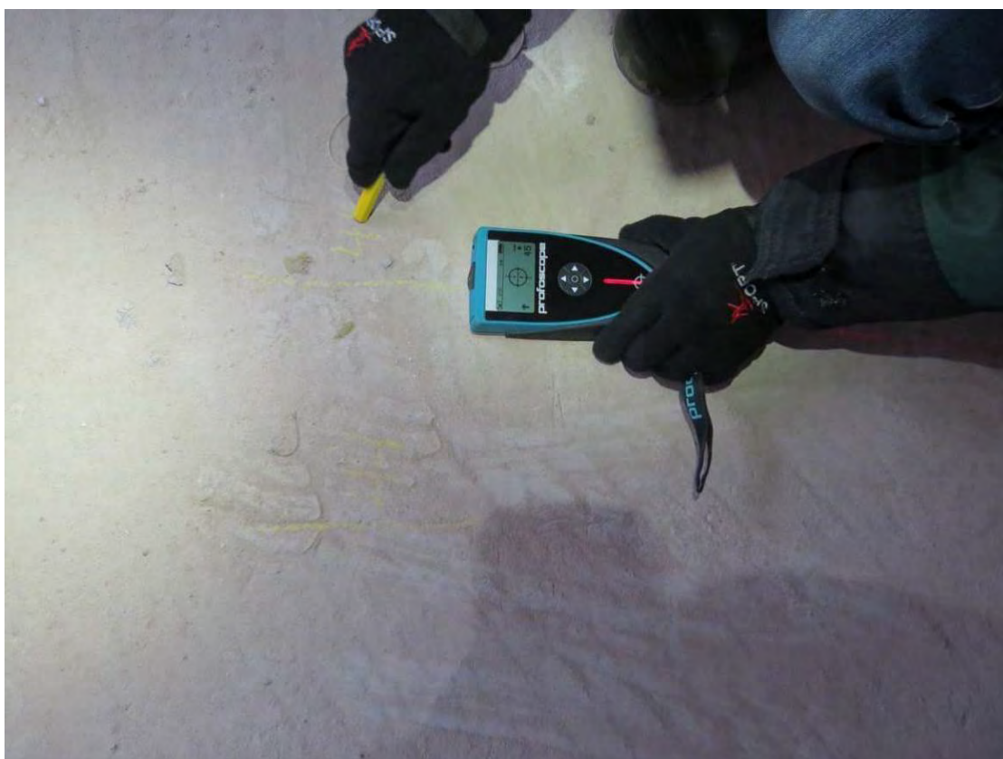
Рис. 3.3.12. Определение положения рабочей арматуры и толщины защитного слоя бетона в монолитной ж.б. плите перекрытия магнитным методом прибором «Profoscope»
