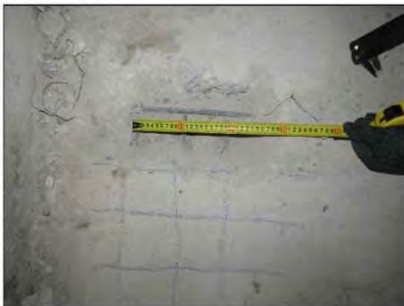
ФОТО 35. Общий вид вскрытия верхней зоны монолитной железобетонной плиты пола седьмого этажа жилого дома между осями А/2-Г/2 / 20/2-21/2.
