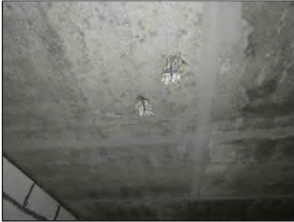
ФОТО 33. Общий вид вскрытия нижней зоны монолитной железобетонной плиты перекрытия седьмого этажа жилого дома между осями А/2-Г/2 / 16/2-17/2.
