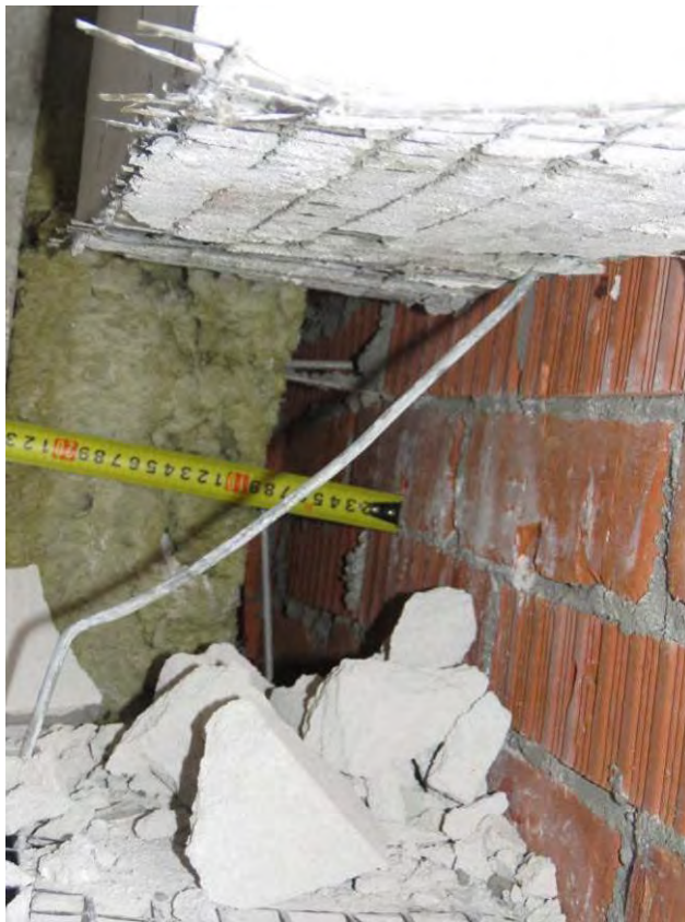
Рис. 3.4.11. Замер величины воздушного зазора в ограждающей конструкции наружных стен примыкающих к пилону в уровне 7-го этажа на пересечении осей А/2, 17/2
