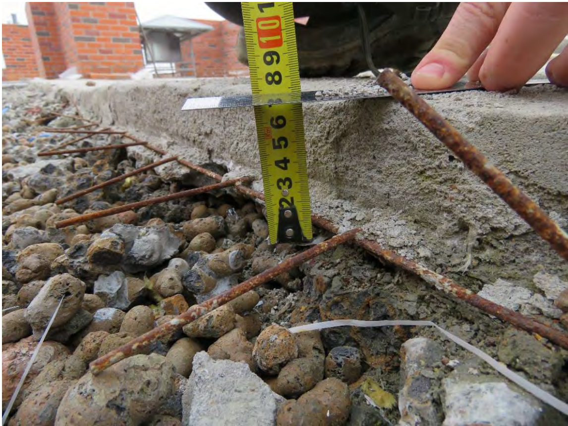
Рис. 3.6.3. Замер толщины стяжки из цементно-песчаного раствора
