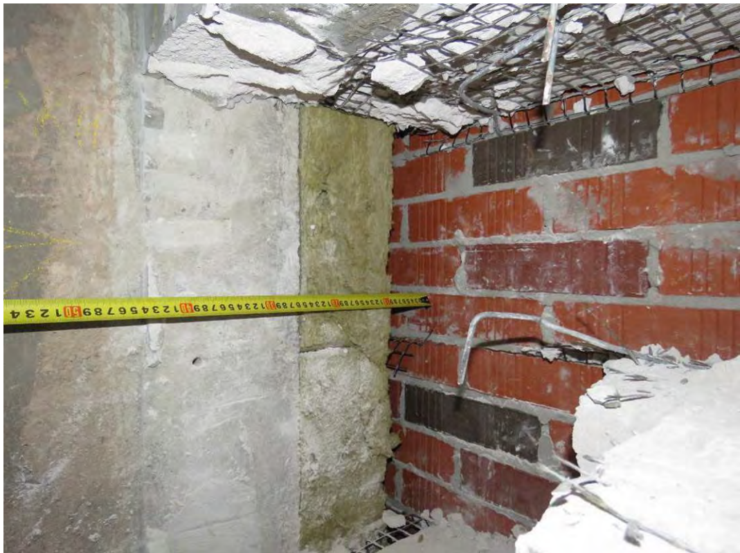
Рис. 3.4.14. Замер толщины утеплителя с воздушным зазором в ограждающей конструкции наружных стен примыкающих к пилону в уровне 3-го этажа на пересечении осей Т/2, 29/2
