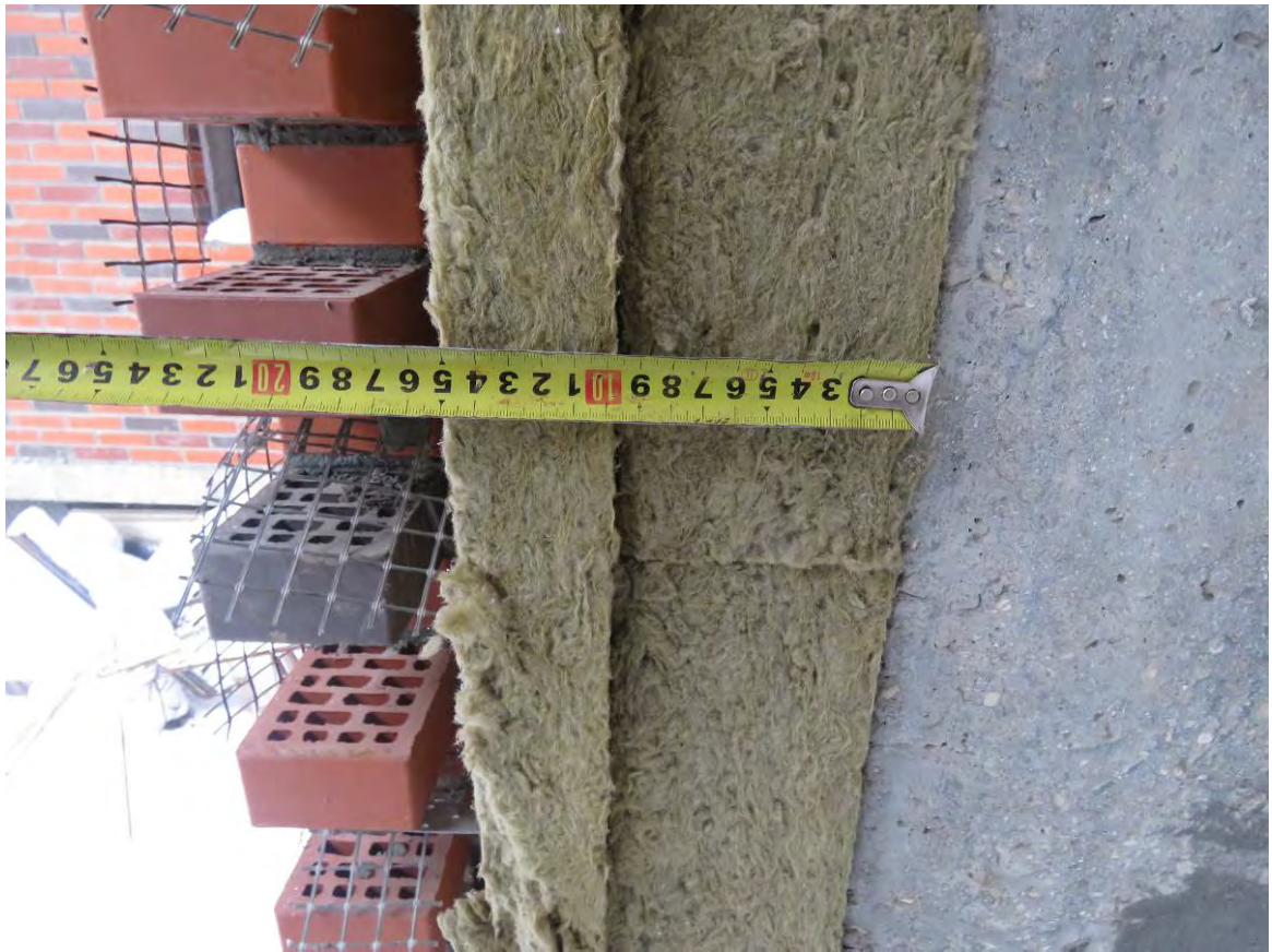
Рис. 3.4.5. Замер толщины утеплителя в наружной стене жилого дома (тип 2)
