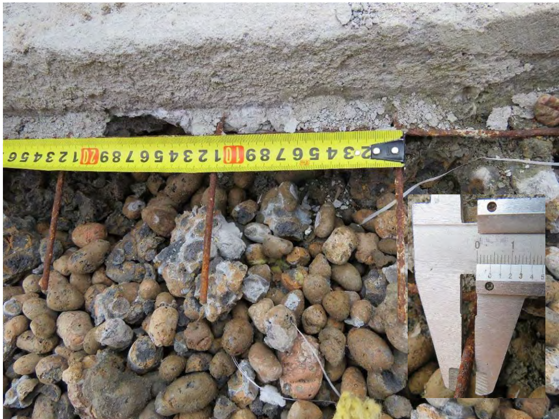
Рис. 3.6.4. Замер геометрических параметров армирования стяжки из цементно-песчаного раствора
