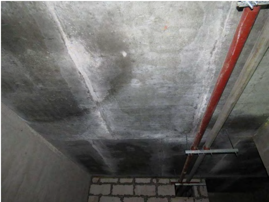
Рис. 3.3.1. Общий вид монолитной ж.б. плиты перекрытия подвала
