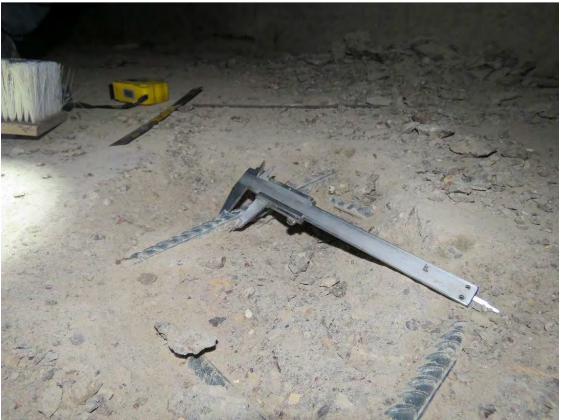
Рис. 3.1.9. Определение диаметра (16 мм) арматуры верхней зоны армирования наращённого слоя фундаментной плиты на участке вскрытия в секции 4 между осями Г/2 – А/2, 27/2-28/2
