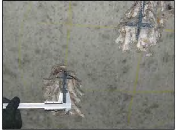
ФОТО 34. Уточнение диаметра рабочей арматуры монолитной железобетонной плиты перекрытия седьмого этажа жилого дома между осями А/2-Г/2 / 16/2-17/2.
