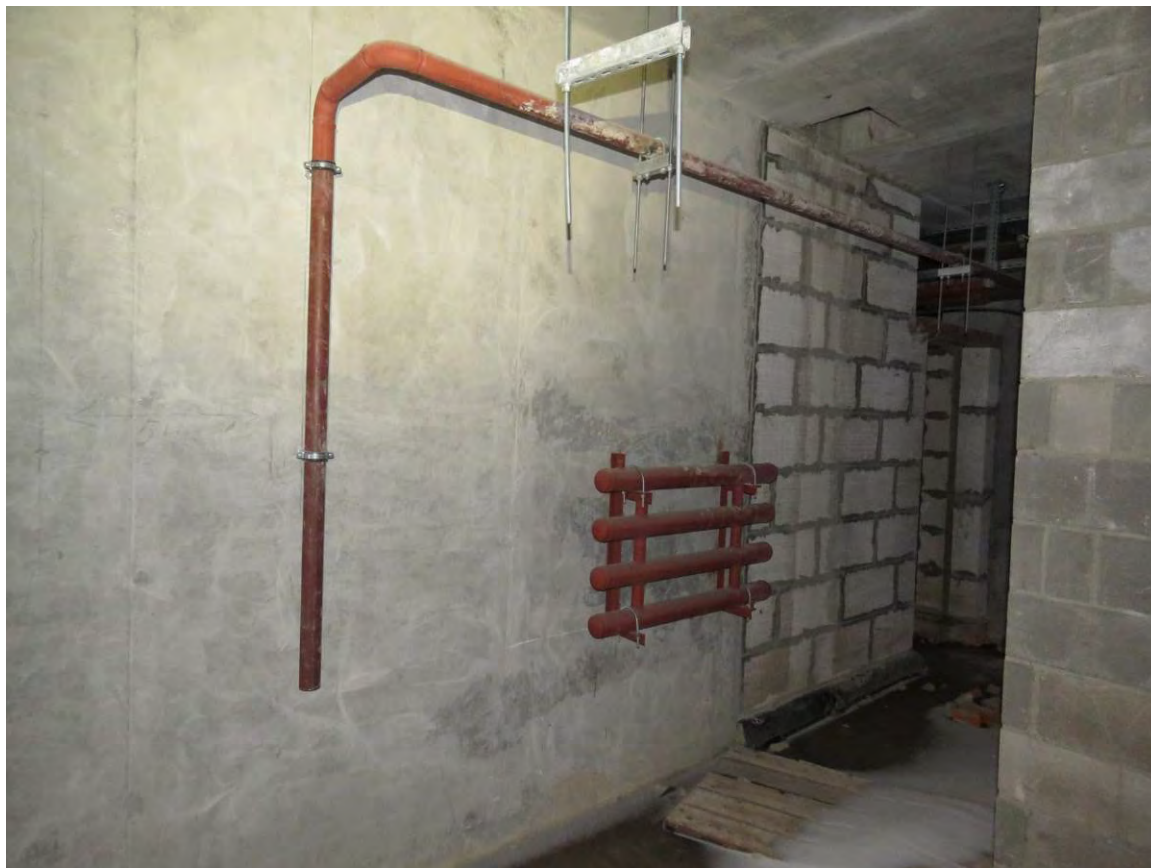
Рис.3.7.1.3. Общий вид регистра из стальных гладких труб
